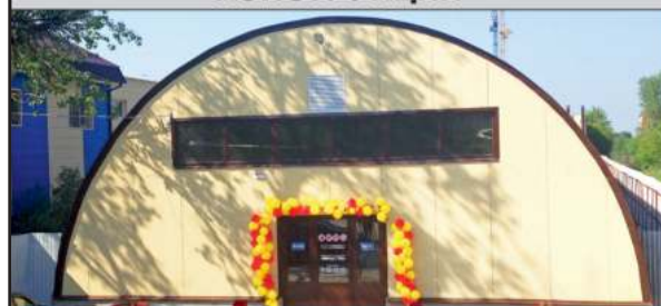
СКЛАДСКИЕ И ПРОИЗВОДСТВЕННЫЕ ПОМЕЩЕНИЯ
